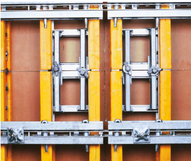
► Schnelle und leichte Verbindung bei Element-aufstockungen mit der MANTO Richtzwinde
