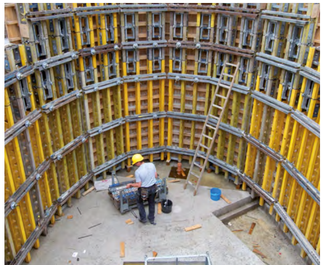
► Gewünschte Elementhöhen können problemlos je nach Sichtbetonanforderung ausgeführt werden.
