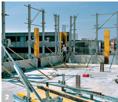
2 Geringe vorzuhaltende Gerätemengen durch vorseilendes Takten.
