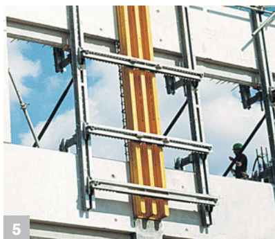
5 Lange Lebensdauer durch Feuerverzinkung aller Stahlteile.
