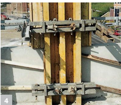
4 Geringe Anzahl von Komponenten (Gurte, Auflager, Riegel, Spanner).
