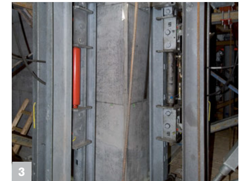
3 Schnelleres Klettern durch großen hydraulischen Hub.
