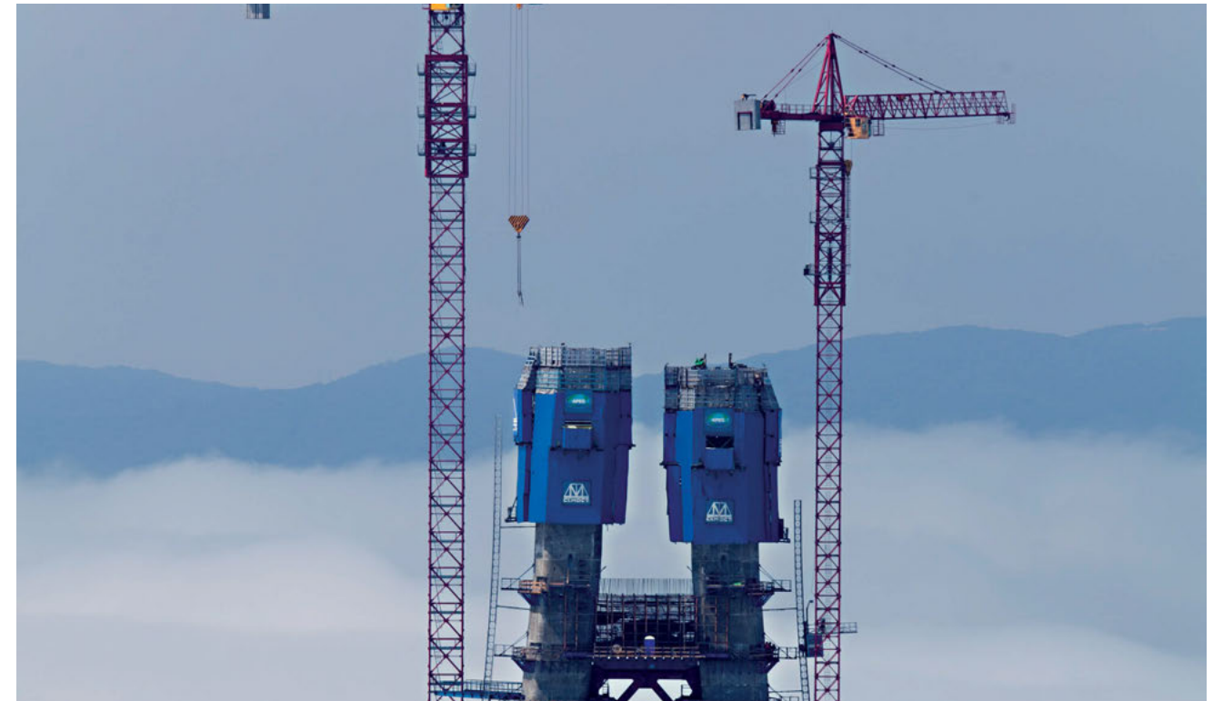
Hoch hinaus: Schalarbeiten in einer Höhe von mehr als 300 m sind für SCF kein Problem.
