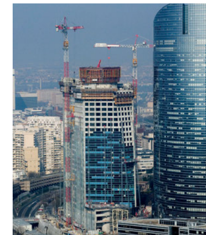
SCF beim Bau eines etwa 200 m hohen Wolkenkratzers mit einer um 8° geneigten Fassade.
