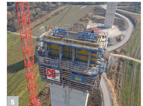
5 Auf allen Ebenen eingehaust, so dass Schutz vor herabfallenden Gegenständen und Wettereinflüssen für Mensch und Material besteht.
