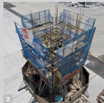
2 Zusätzliche Arbeitsbühnen oberhalb der Schalung für vorlaufende Bewehrungs- und Betonierarbeiten.
