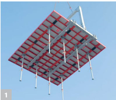
1 Tischflächen bis zu 26 m 2 schnell in nur einem Kranhub umsetzbar.
