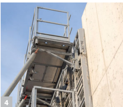
4 Seitengeländer sind mit einer Sicherheitsmechanik gegen unbeabsichtigtes Herausheben gesichert.
