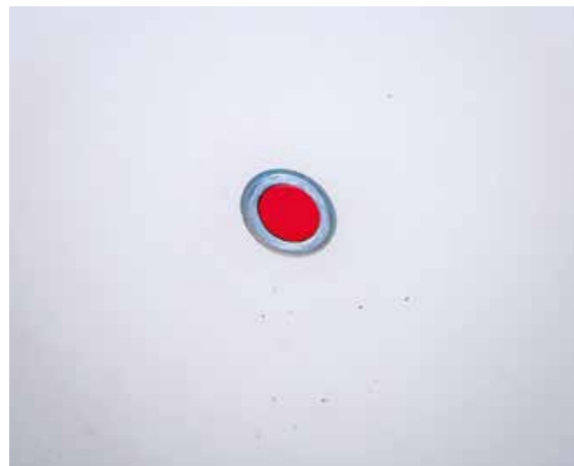
► Stahlummantelte Ankeröffnung mit Dichtkonus
