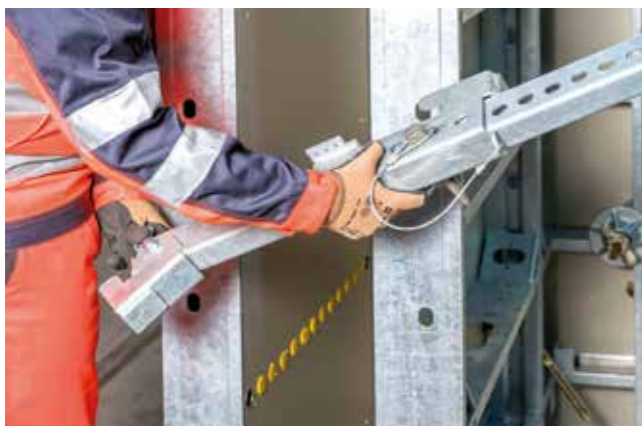
► Abschaltzwinge für zug-druckfeste Stirnabsperungen mit nur einem Teil
