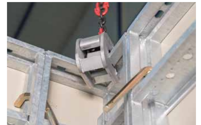
► Mit dem Transporthaken sind die Ecken zudem zentrisch angeschlagen umsetzbar.
