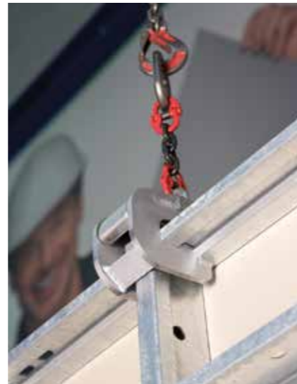
► Der mittlere Vertikalriegel bietet Anschlussmöglichkeiten für den Transporthaken in der Mitte der Tafel.
